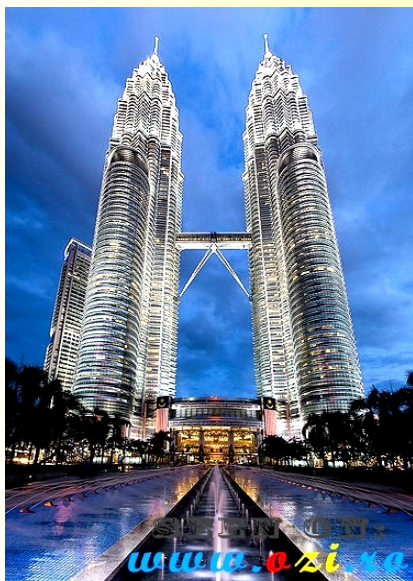
3. Turnurile Petronas din Kuala Lumpur, Malaiezia au fost construite in 1998 si au o inaltime de 452 metri (88 etaje), fiind astazi cele mai inalte turnuri gemene din lume.
